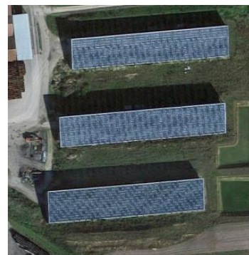
Toiture PV agricole à Brouchy 2
